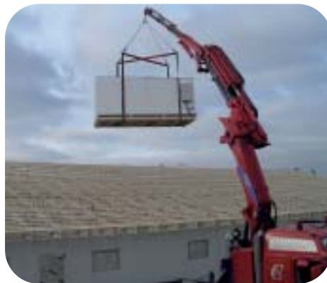
Det tog kun halvanden time at få reenseenhederne sat på plads.
