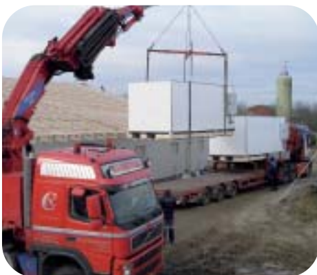
De enkelte reenseenheder er samlet hos SKOV og er klar til at blive løftet på plads.
