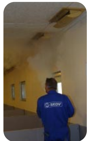
Her kontrolleres lufthastigheden i en tom sti med loftsventiler.
