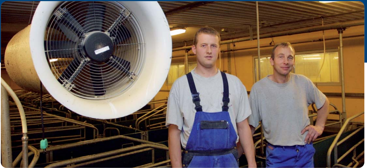
Anders Espersen, til venstre, og Jens Vigh Riis i en af de seks farestalde, hvor de i sommer har monteret luftomrørere for at øge luft hastigheden og dermed gøre det køligere for søerne.
