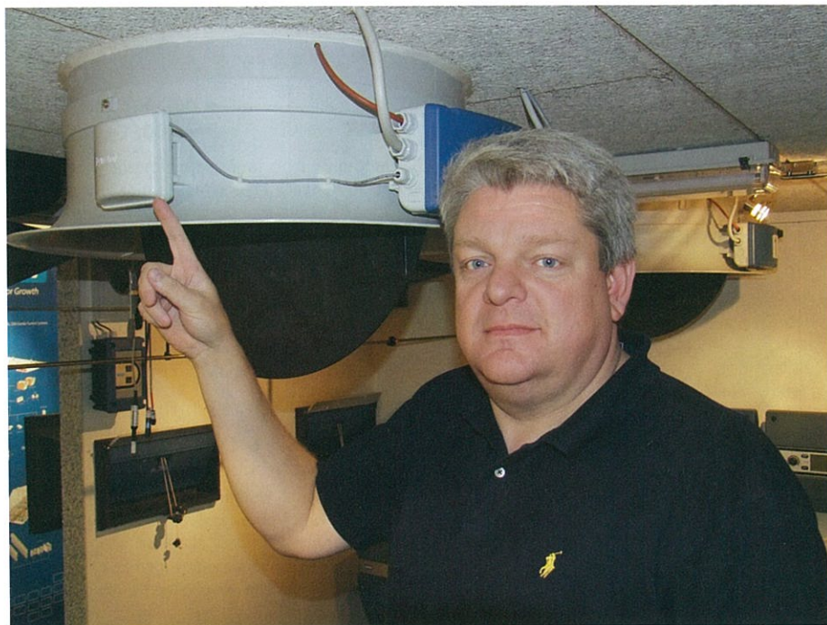
Dynamic Air er en trykmåler, som sættes på ventilatoren. Michael Tækker viser placeringen af boksen, hvor trykmåleren sidder. Ligesom en målevinge måler luftgennemstrømningen i skorstenen. Det sker bare uden mekaniske dele i luftstrømmen, som koster kompensationsenergi.
