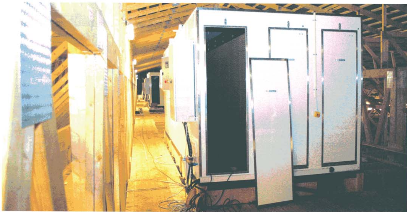
En af de tre biologiske luftrensingsmoduler på loftet af den nye smågrisestald. Selve huset er fremstillet af et firma, der normalt laver pølsevogne. Hvert modul koster omkring 250.000 kroner.
