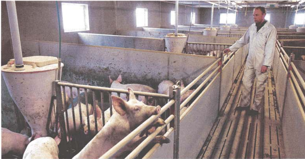
Niels Ejnar Rytter har valgt spaltegulv på midtergangen af hensyn til hygiejnen. Stalden er i vid udstrækning bygget af præfabrikerede betonelementer, og stisiderne er også af beton.
